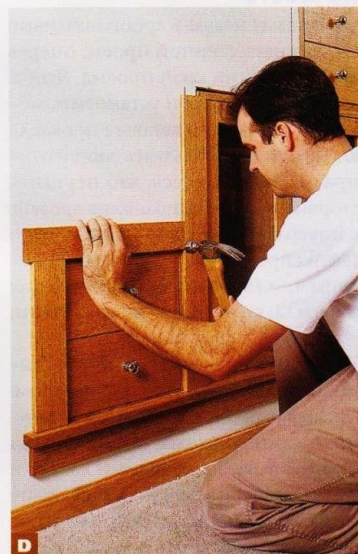
D Расположите все вертикальные и горизонтальные наличники таким образом, чтобы вокруг модуля получился пластик шириной 6 мм.
