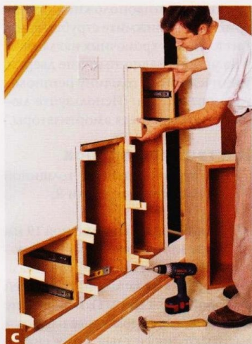
C Чтобы выставить модули в проемах вертикально, вставьте прокладки между модулями и стойками каркаса стены.
