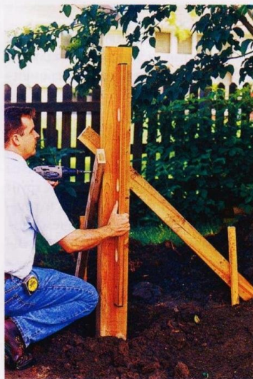
Строительным уровнем проверьте вертикальность двух смежных граней столба и зафиксируйте его положение временными подкосами и колышками.
